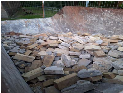
April 2024 - Abriss hat begonnen
