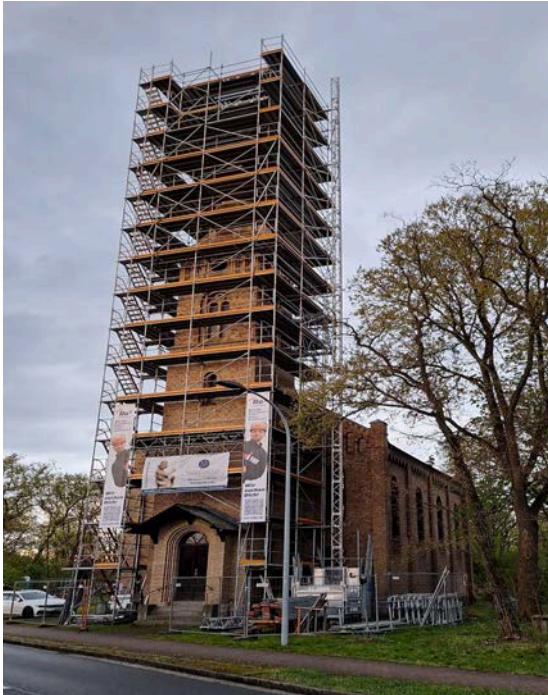
April 2024 - das Gerüst steht
